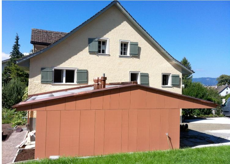
Die rohen Bruchsteinwände wurden mit Kalkstopfmörtel (Baustellenmischung) neu gefestigt, dann wurden die Aussenwände mit bis zu 8cm Schichtdicke mit einem Kalkdämmputz gedämmt. Darauf folgte der Kalkgrundputz und der Sumpfkalkfeinputz.
