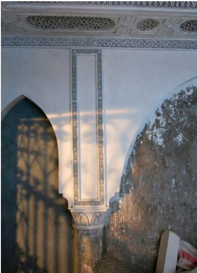
Frische Gipsschnitzereien auf der Baustelle Plâtrerie fraîche dans un chantier.
