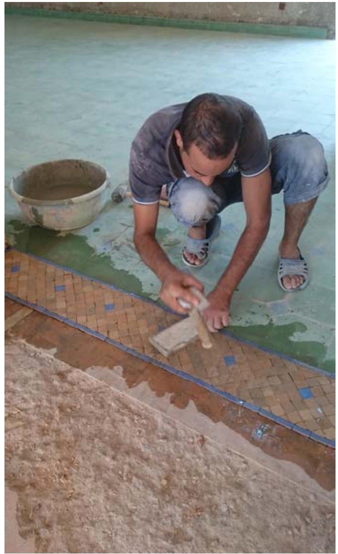
Die zugehauenen Zelligestücke werden verlegt, danach gut gewässert und mit einem Brett eben eingeklopft. Les carreaux de Zellige taillés seront posés, ensuite bien humidifiés et mis à plat avec une planche.
