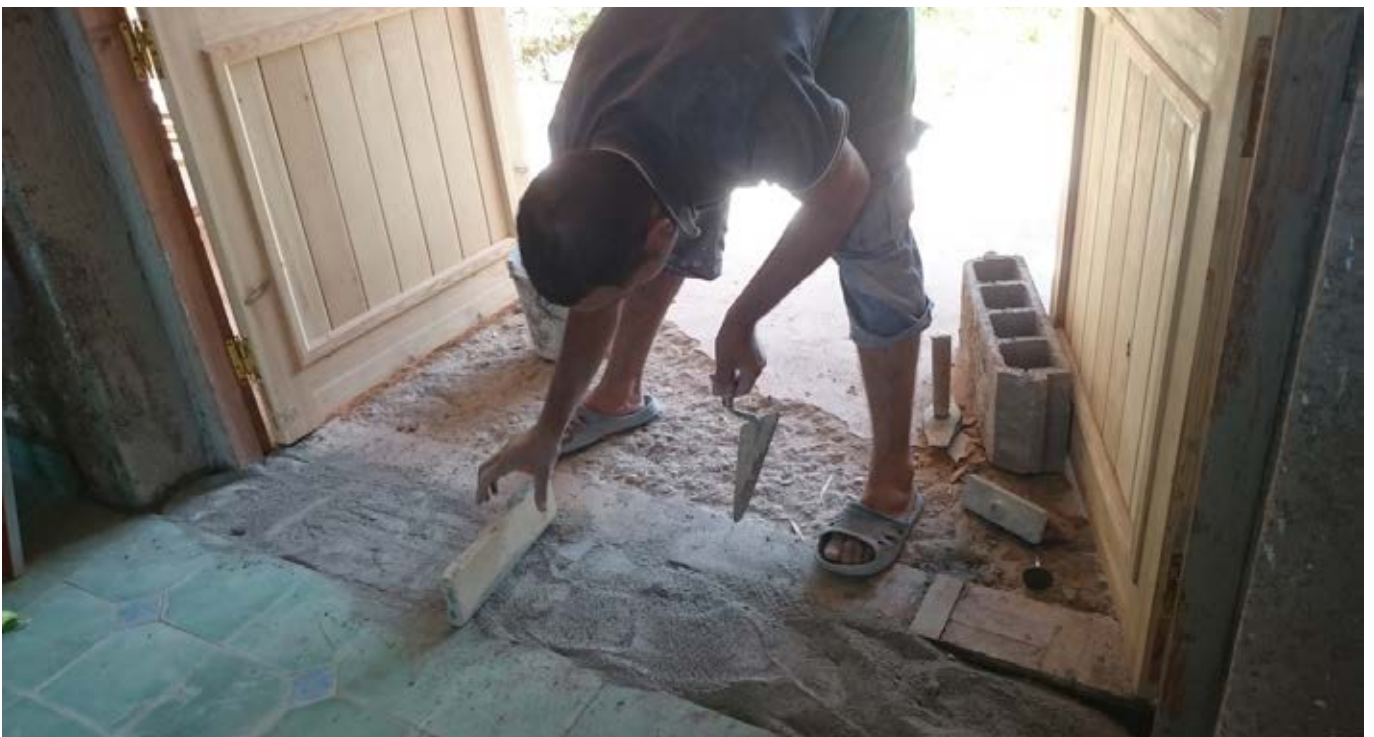
Ein Gemisch aus Sand und Zement (Überzug) wird eingebracht und egalisiert. Un mélange de sable et de ciment (revêtement) est déposé et égalisé.
