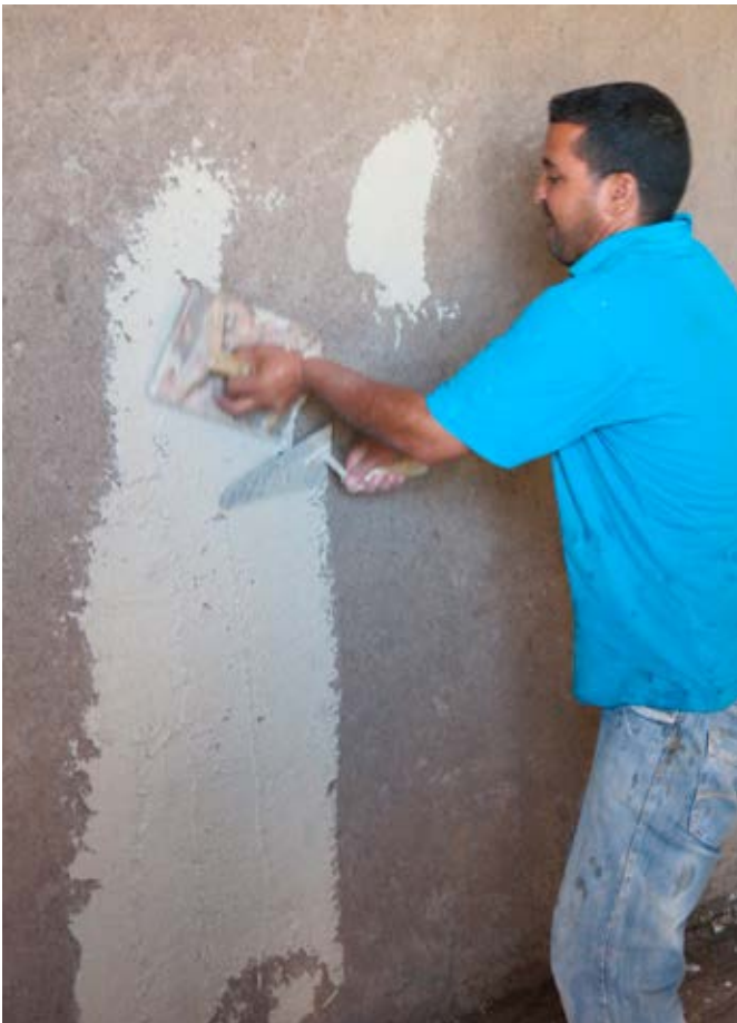
Der Meister zeigt wie es geht und bringt den Tadelakt an die Wand. Le Maître montre comment cela fonctionne et met le Tadelakt sur le mur.
