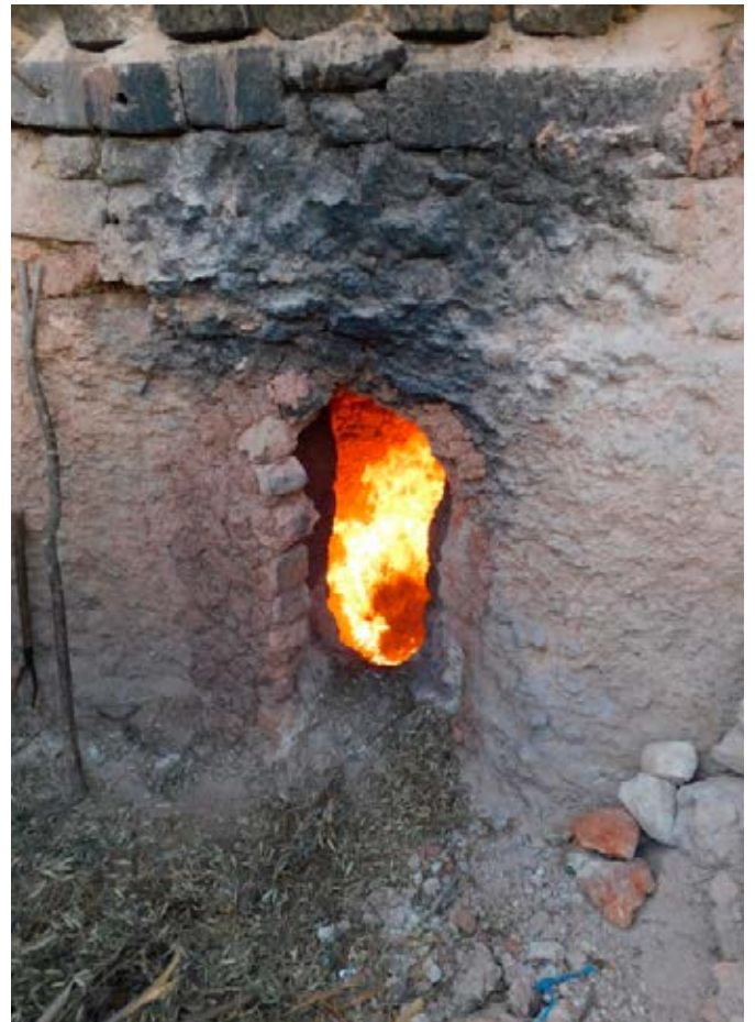
Das Feuertor... L'entrée du foyer...
