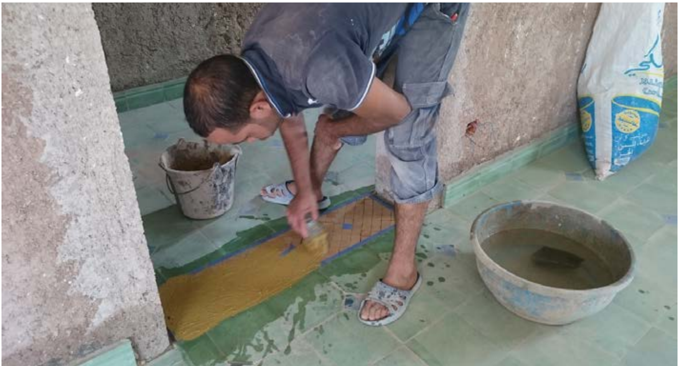
Das Verfugen erfolgt mit einer Bürste. Le jointoyage est fait avec une brosse.
