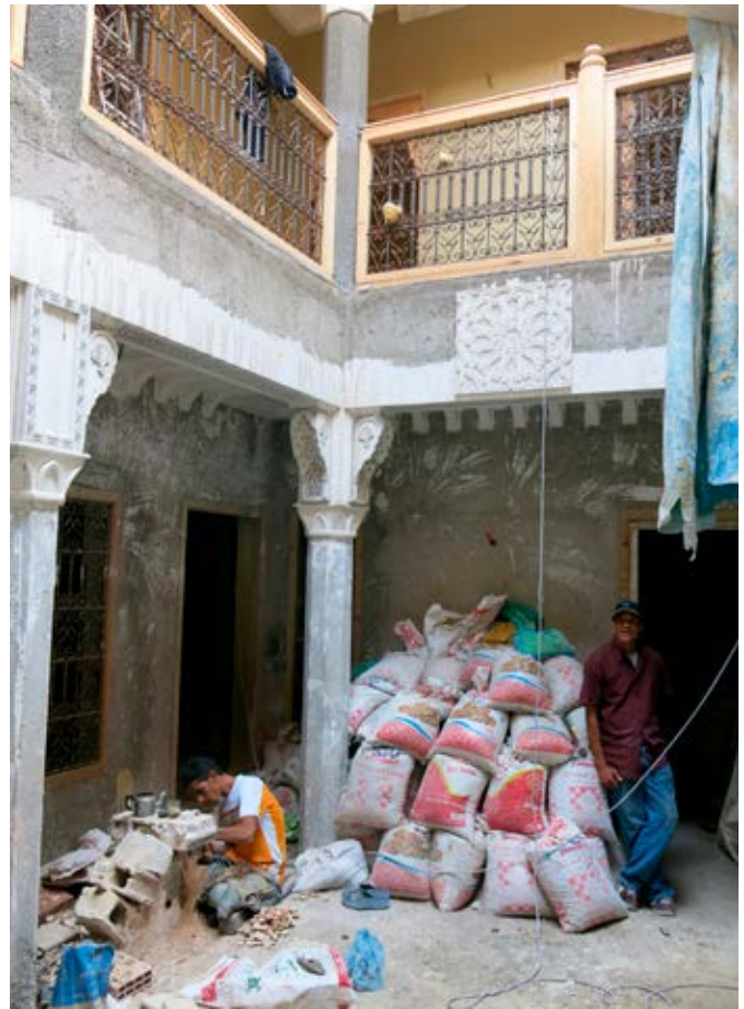
Auf der Baustelle in Marrakech Dans un chantier à Marrakech.
