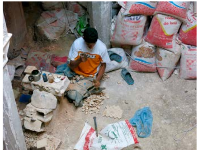
Mosaik wird auf der Baustelle geschlagen Les Mosaïques sont brisées sur le chantier.
