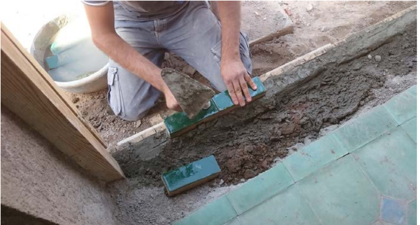
Kupfergrünes Randstück wird gesetzt. La bordure en chrysocolle est mise en place.
